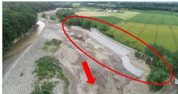
○復旧工事完成
