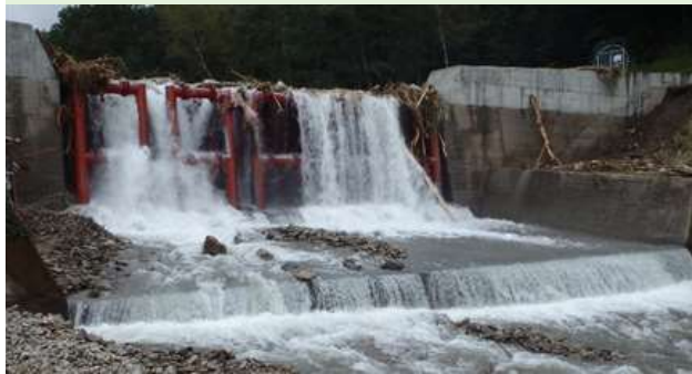
土砂災害から人や財産を守るため、砂防えん堤等の整備を行う。
