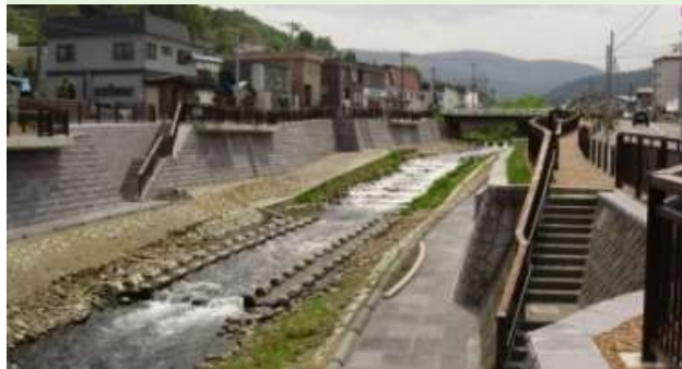
水辺環境に配慮しながら、堤防や護岸などの河川整備を行う。
