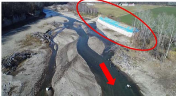
○復旧工事着手前(応急工事で土のうシート設置済)
