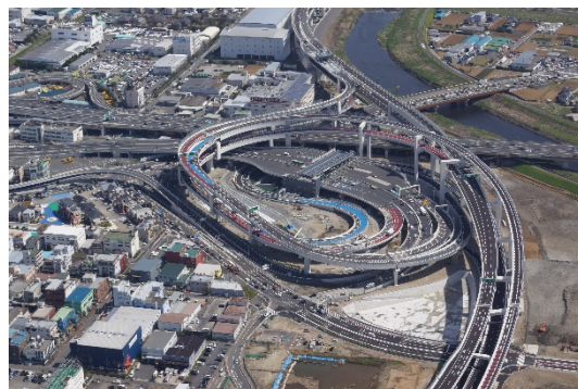
横浜港北ジャンクション高架橋 令和元年度土木学会賞田中賞作品部門 (写真提供: 首都高速道路(株))
