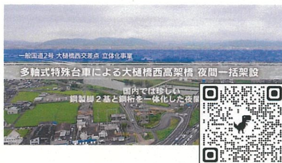
【大樋橋西高架橋】07:30
