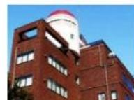
東京本社 1997年施工自社ビル
