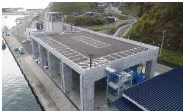
避難施設の整備
