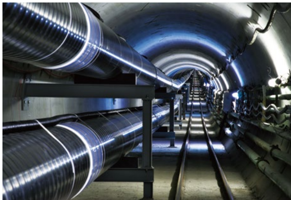
名古屋港を海底シールドトンネルで横断し、最新鋭の火力発電所に天然ガスを供給するパイプライン
