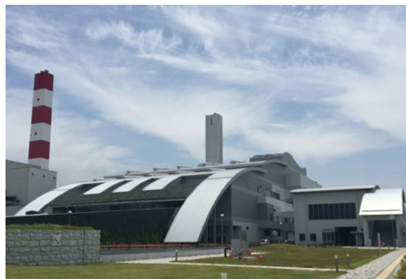
熊本市と推進する地域新電力が主体となり、 災害時でも安定した電力を周辺地域へ供給する 熊本市・西部環境工場
