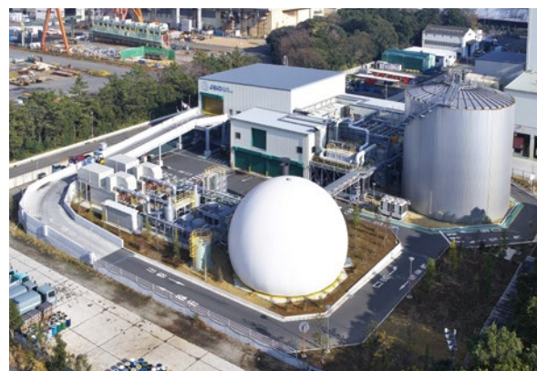
食品廃棄物をバイオガス発電により電気にリサイクルする 神奈川県・(株)Jバイオフードリサイクル 横浜工場
