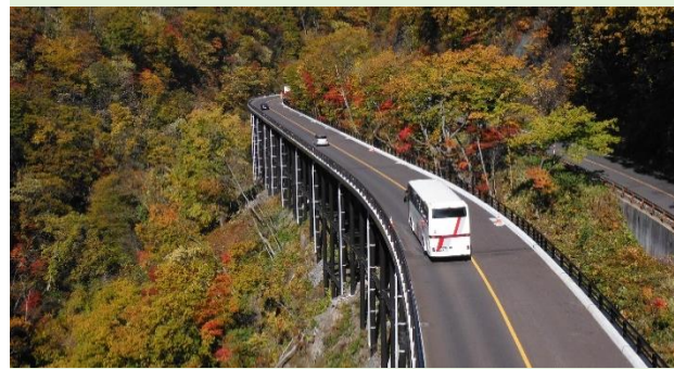
道路網の整備や道路の防災対策、老朽化対策、交通安全対策などの道路整備を行う。
