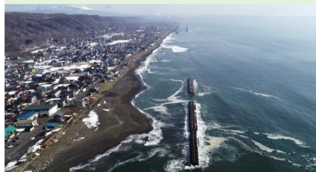
高潮・津波・砂浜の侵食から生命財産を守るため、海岸保全施設の整備を行う。
