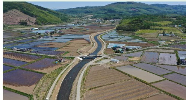
洪水から家屋や農地を守るため、河道掘削や堤防などの整備を行う。
