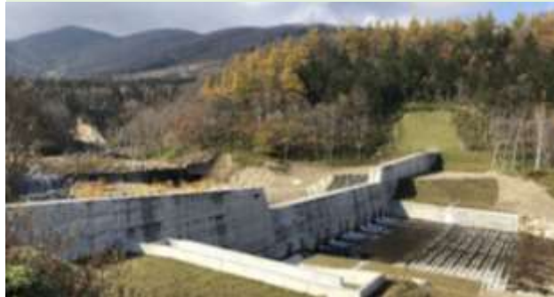
土石流から生命財産を守るため、砂防えん堤などの整備を行う。
