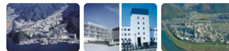
高知工場 新規技術研究所/セメント・コンクリート研究所 岐阜工場
