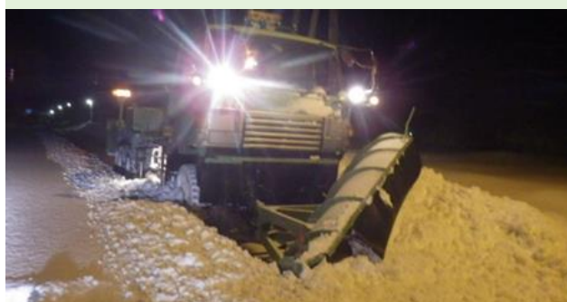
道路・河川等の巡視や点検・補修、道道の除排雪などの維持管理を行う。
