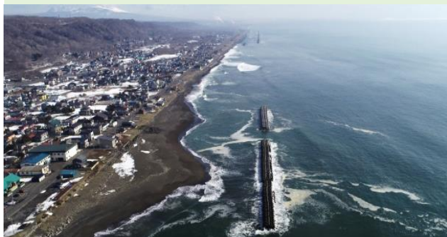
高潮・津波・砂浜の侵食から生命財産を守るため、海岸保全施設の整備を行う。
