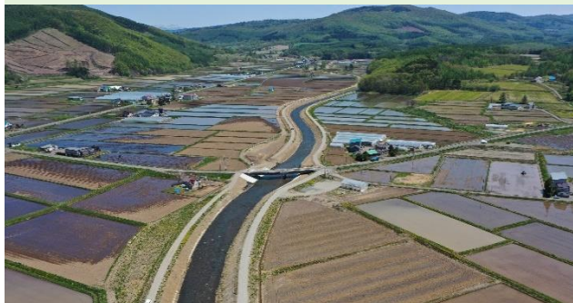
洪水から家屋や農地を守るため、河道掘削や堤防などの整備を行う。
