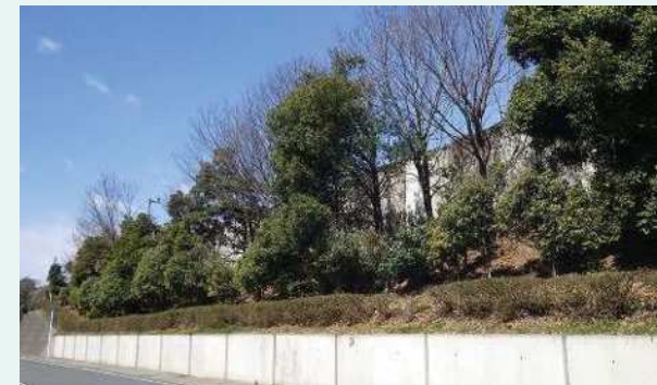
土工・のり面
