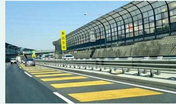
舗装・ガードレール
