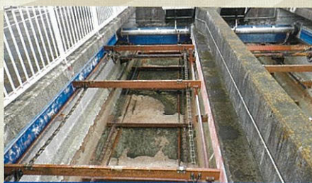
北勢沿岸流域下水道(北部・南部処理区)北部浄化センターほか水処理設備改築詳細設計:三重県川越町亀崎新田
