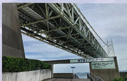
舞子海上ブロンナード補修設計:兵庫県神戸市 兵庫県神戸土木事務所
