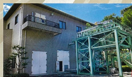
宮津湾流域下水道宮津湾浄化センター耐震診断:京都府宮津市
