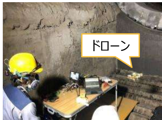
ドローンによる焼却炉内点検
