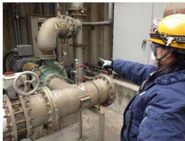
③現場点検
