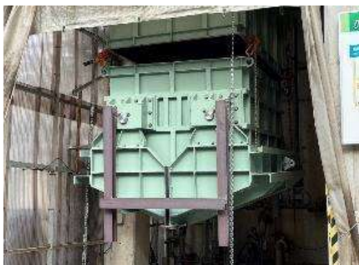
工事立会(廃液処理工場)
